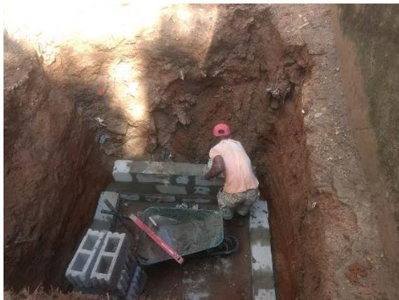
外トイレ設置の様子
