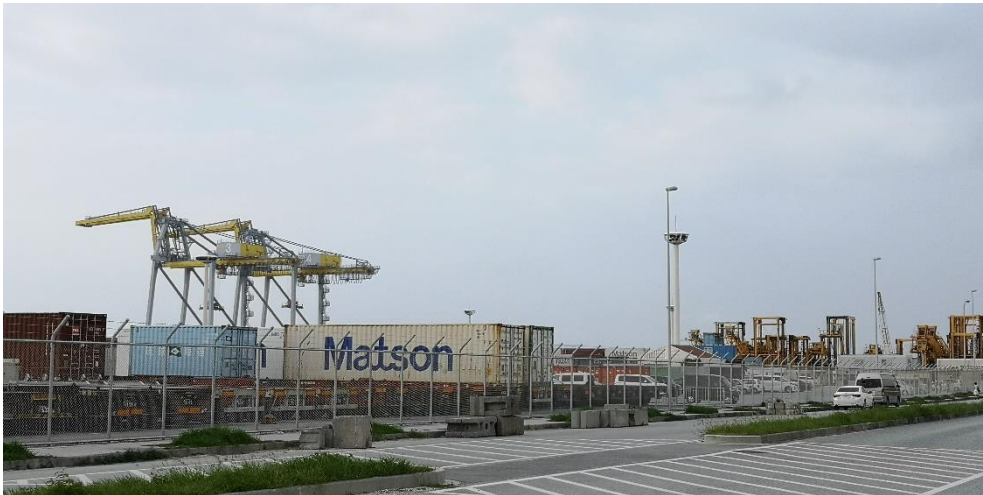
図2 那覇港国際コンテナターミナル ガントリークレーンが見える
