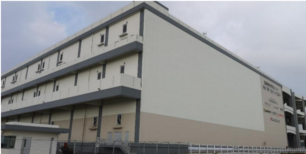
図 13 那覇港総合物流センター外観
