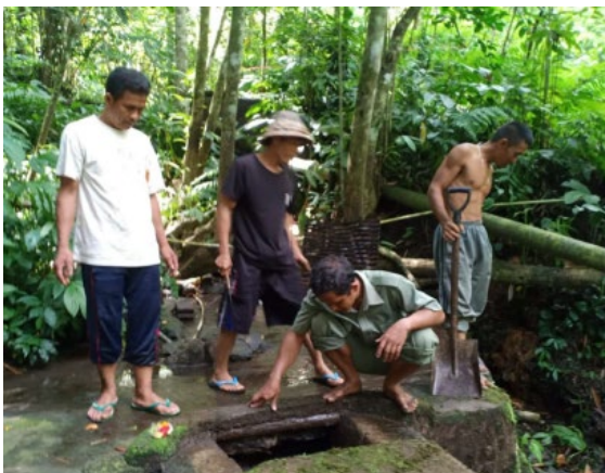
給水設備の維持管理研修
