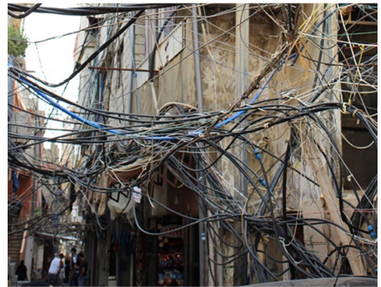
電線と配水管が絡み合う 難民キャンプ内の通り(写真3)
