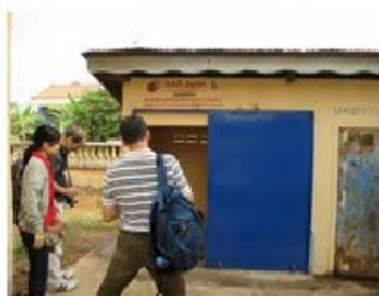
スパイ・ロミアット小学校 障害者用トイレ
