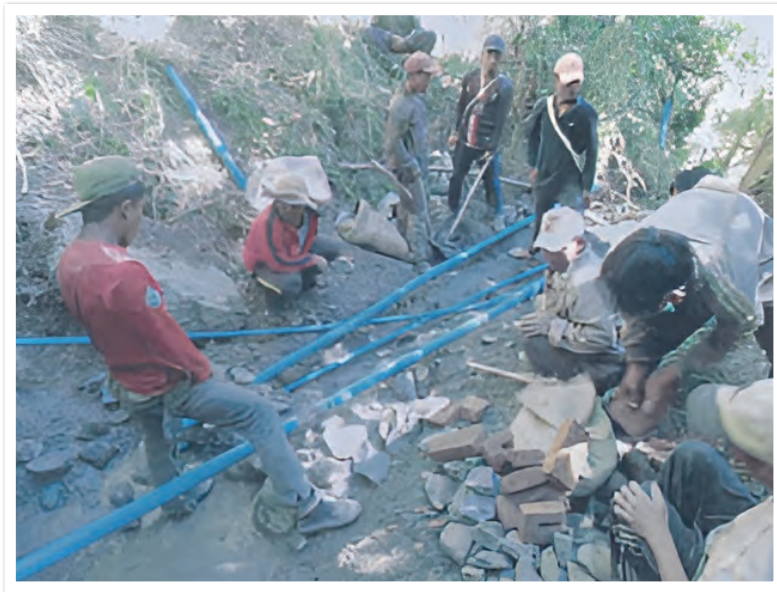
（写真1）地域住民が参加して塩化ビニルパイプを配管している様子
