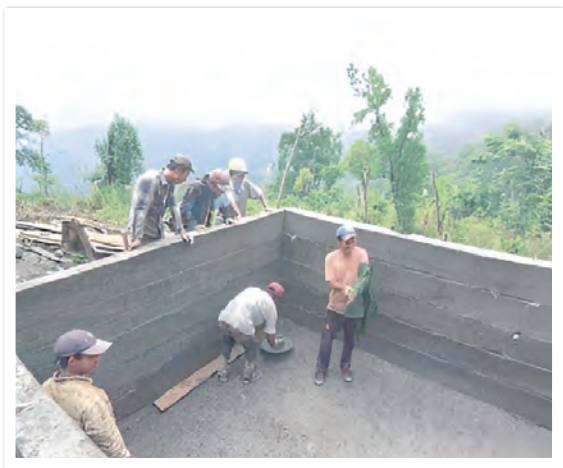
(写真2) 貯水タンクを建設している様子
