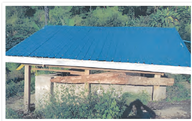
(写真3) 完成した貯水タンク
